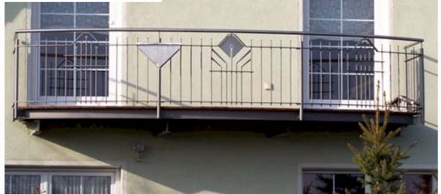
06 Balkongeländer aus feuerverzinktem Stahl, lackiert, mit Edelstahlhandlauf
