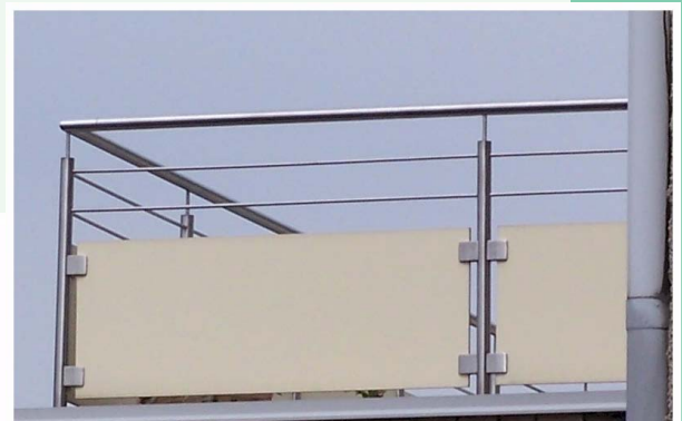
Balkongeländer aus Edelstahl mit horizontalen Rellingstangen, Füllung aus Tresaplatten
