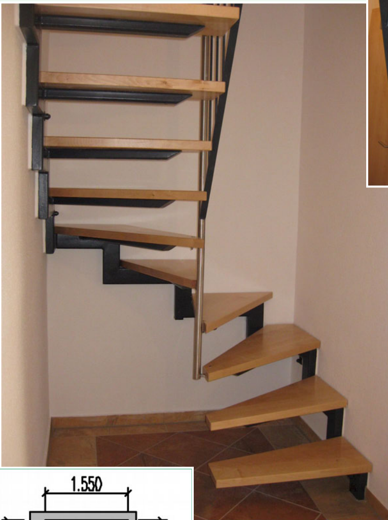
02 Wandholmtreppe \frac{3}{4} gewandelt mit minimalem Raumbedarf in schmalen Flur 15 Stg. Geschosshöhe 295cm
