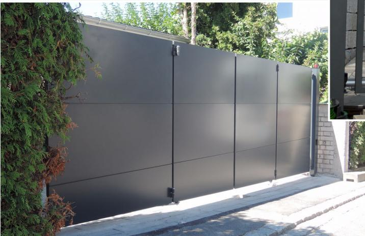
Abb. 29 - Falttor 2flg. mit Aluminiumblechbekleidung
