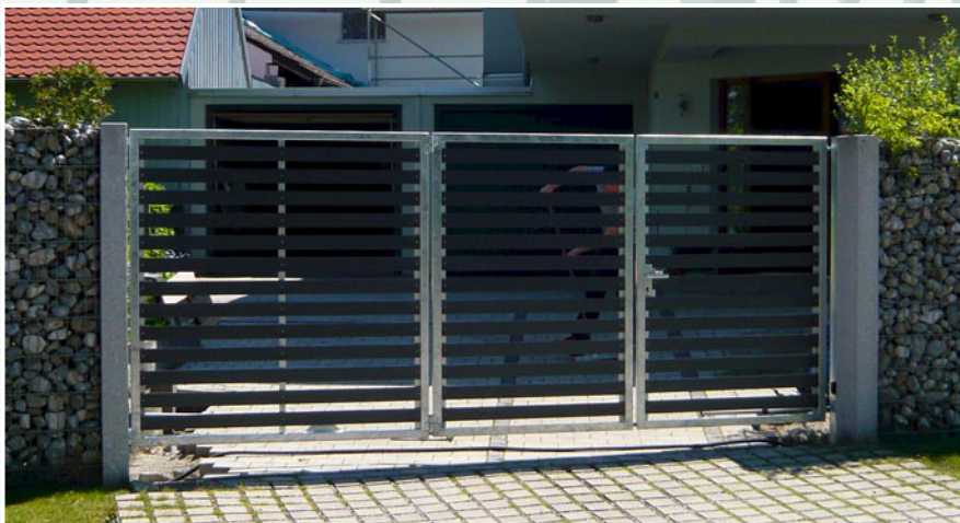
Abbildung 1: 3-teilige Toranlage mit Schlupftür (rechts) und Faltflügel (links)
