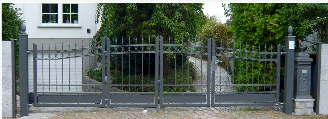
Abbildung 3: 4-teilige Toranlage mit Doppelfaltflügel (links) und Schlupftür (rechts)
