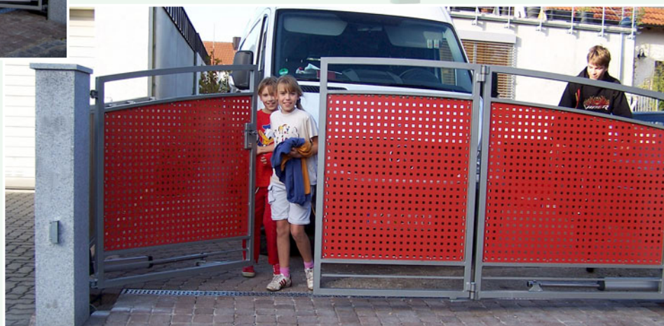
Abbildung 2: 3-teilige Toranlage mit Schlupftür (links) und Faltflügel (rechts)
