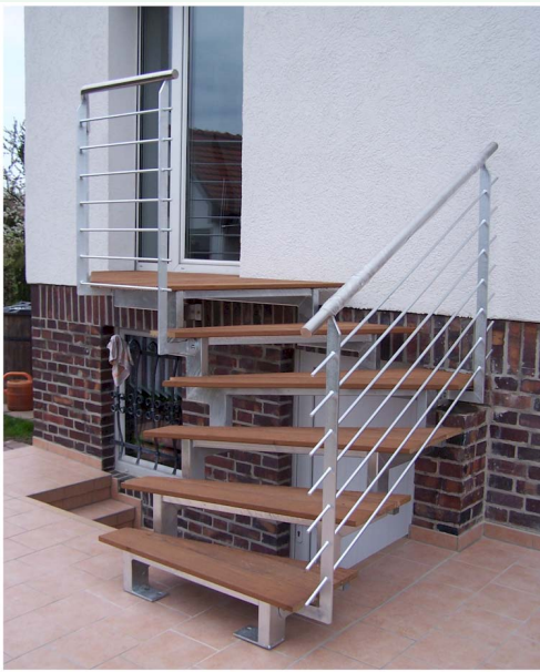
06 2-Holmtreppe 1/4 gewendelt, mit Austrittspodest, Stufenbelag Bankirai, Stahl-Relinggeländer, feuerverzinkt
