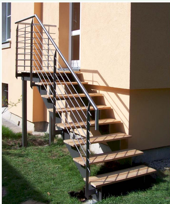
01 Gerade Wangentreppe mit Austrittspodest, Stufenbelag Bankirai, Stahl-Relinggeländer
