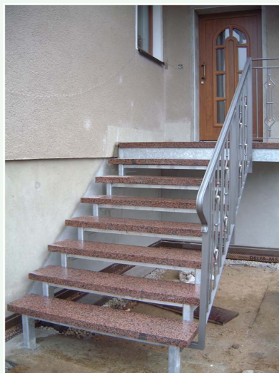
2-Holmtreppe mit Podest, Natursteinstufen, schmiedeeisenes Geländer feuerverzinkt
