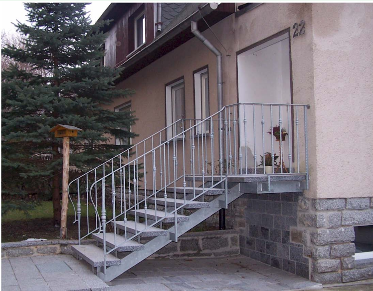
08 Gerade U-Profil-Wangentreppe mit Austrittspodest, aufgesattelte Natursteinstufen, schmiedeeisenes Geländer feuerverzinkt
