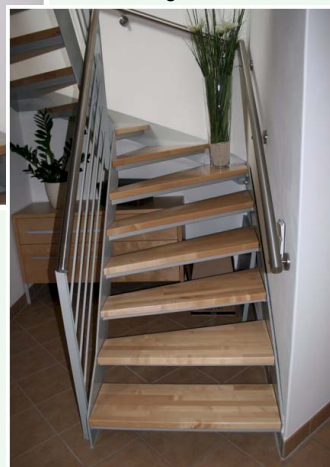
10 Flachstahlwangentreppe ½ gewandelt, Holzstufen mit Tragwanne
