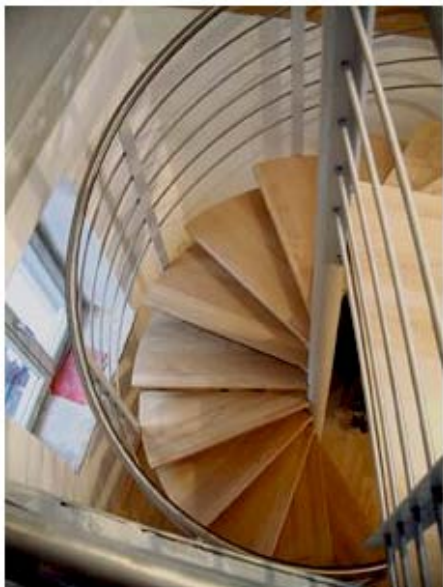
Spindeltreppe mit Podest, Holzstufen, Rellingeländer mit Edelstahlhandlauf
