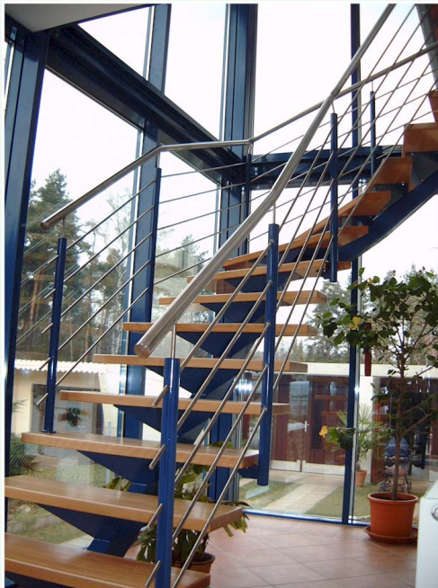
05 Mittelholmtreppe 1/4 gewandelt, Holzstufen
