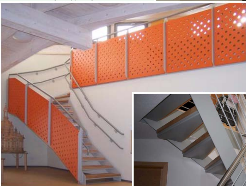
09 Flachstahlwangentreppe ¼ gewandelt, Holzstufen
