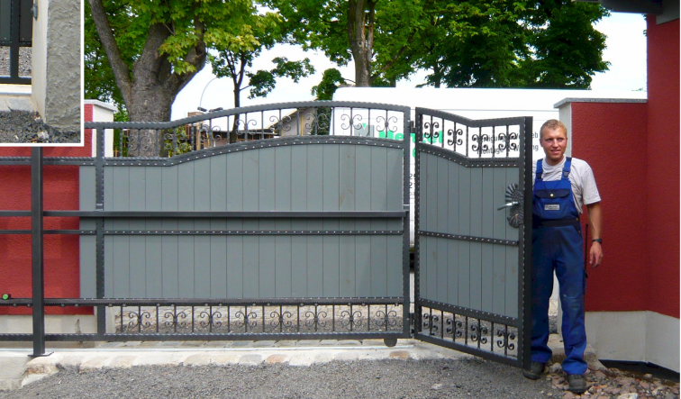
Abbildung 17: Schlupftür XL in Verbindung mit Schiebetor
